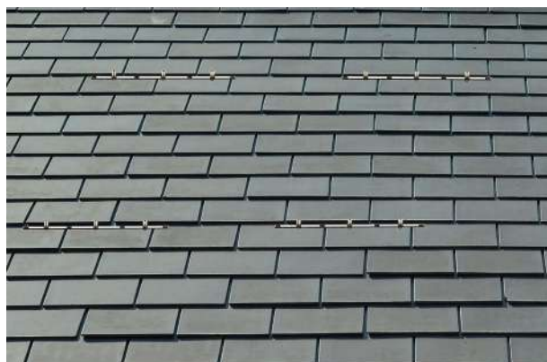
Illustration 5 : Configuration finale de la structure avec 4 capteurs
