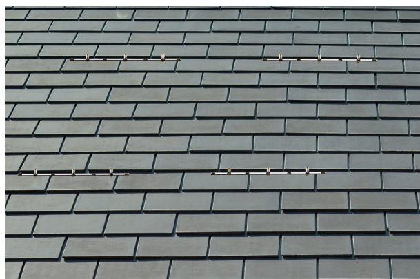
Illustration 5 : Configuration finale de la structure avec 4 capteurs
