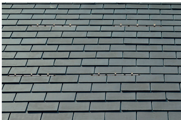
Illustration 5 : Configuration finale de la structure avec 4 capteurs
